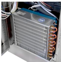
Condensateur protégé par des filtres pour assurer un fonctionnement optimal dans le temps.
